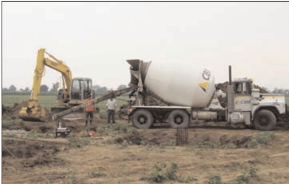
Juillet 2007 – Coulage de ciment dans le cadre de la construction d'une base pour le mât de mesure des vents permanent.
